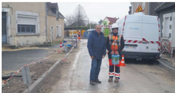
Le maire Roger Chevreton fait régulièrement le tour des travaux. (Photo NR)
