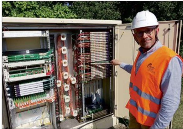
ARMOIRE DE FIBRE OPTIQUE. Laurent Roussat, directeur de Berry fibre optique, présente une armoire de fibre optique, permettant aux opérateurs (à gauche) de raccorder les administrés (à droite). PHOTO BENOIT MORIN
